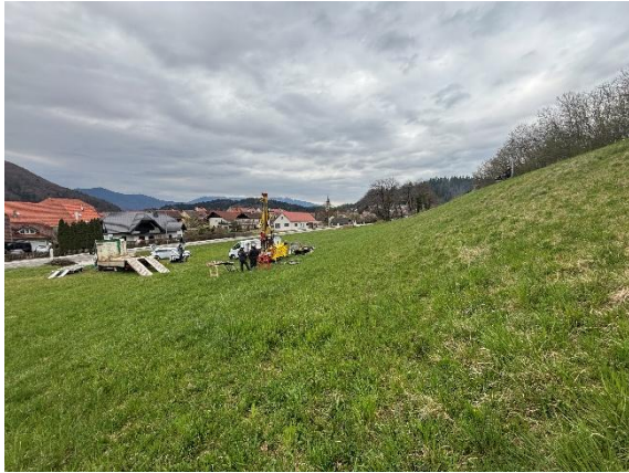
Slika 13: Lokacija geotehnične vrtine GV 1
