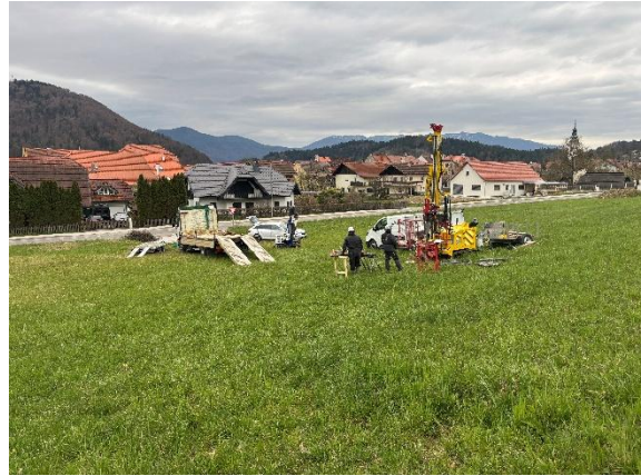
Slika 14: Lokacija geotehnične vrtine GV 1
